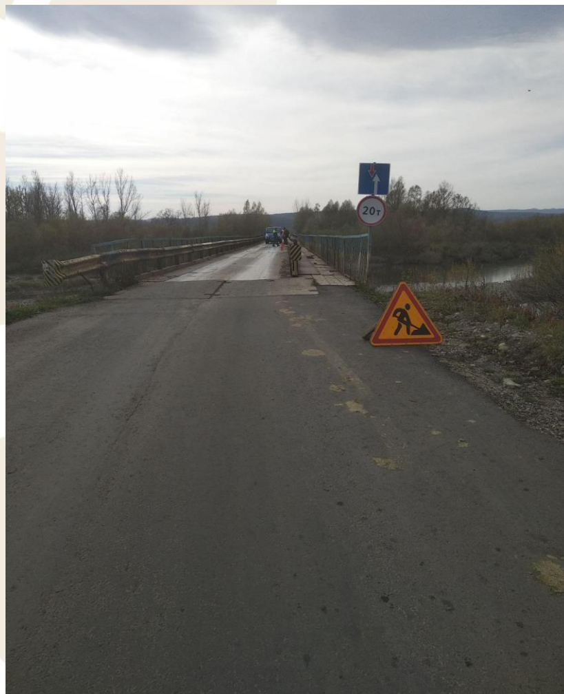
Ремонт моста через річку Прут
